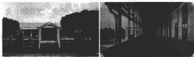
写真5 門柱と正面階段 写真6 2階廊下
