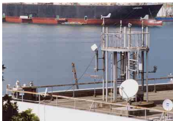
写真 長崎海洋気象台の測風塔
